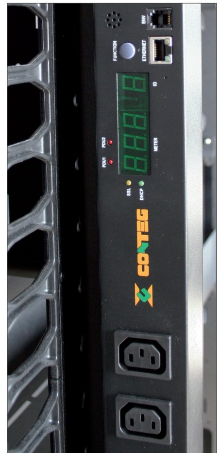
Monitorovaný napájecí panel
