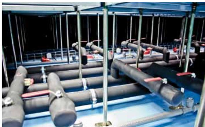
*Distribution de réfrigération sous le plancher*
