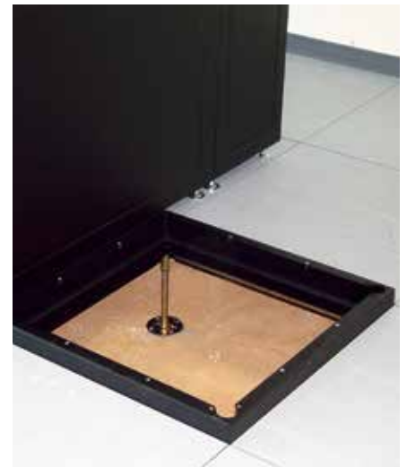
Ein verschweißter Rahmen ersetzt eine Bodenfliese und ermöglicht eine gute Positionierung des Schrankes auf der Doppelbodenkonstruktion.
